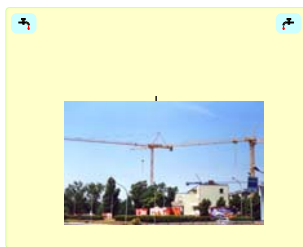
Foto 1. Fase finale di costruzione
